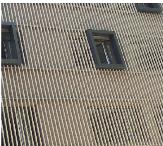
Panneaux à claire-voie aluminium sur crémaillères métalliques P. 10
